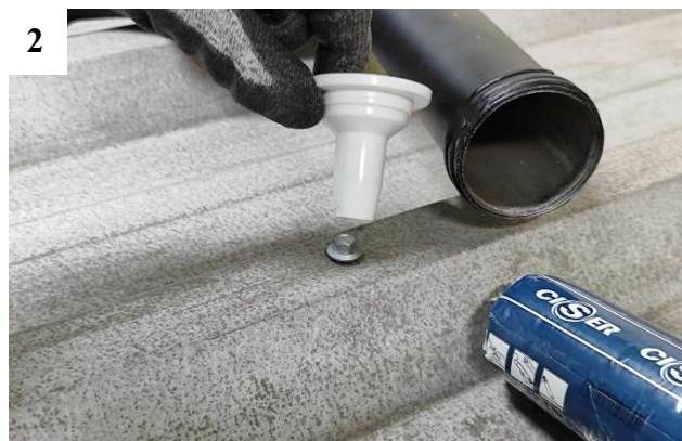
2 Com diâmetro um pouco maior que a cabeça do parafuso
