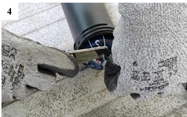
4 Corte a ponta do sachê com estilete ou tesoura
