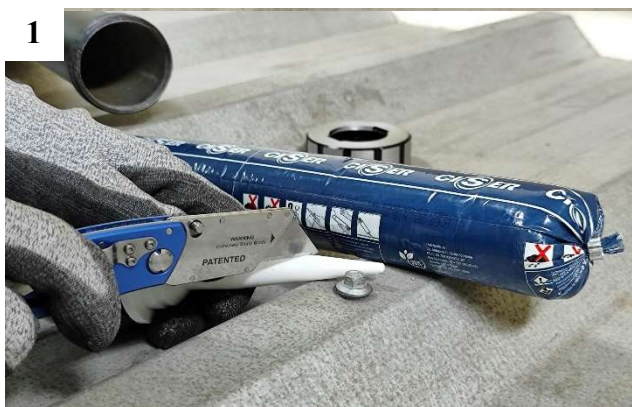
1 Corte a ponta do bico aplicador
