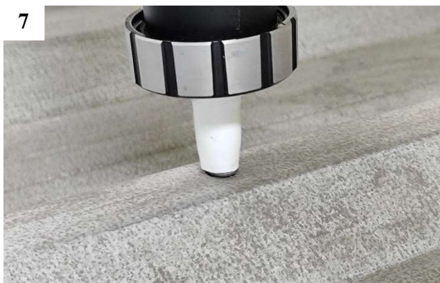
7 Aplique o selante no parafuso a 90°
